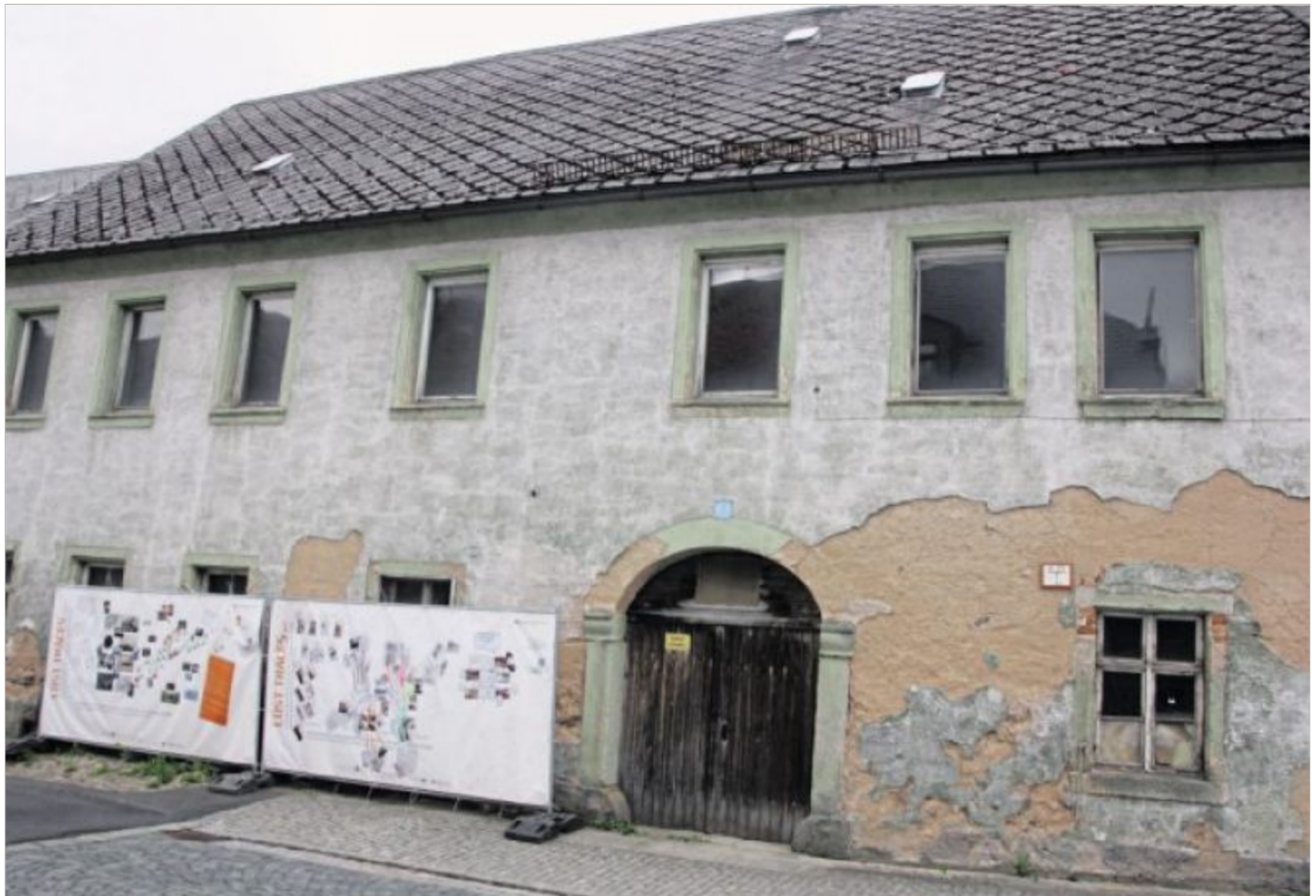
Das heruntergekommene Ackerbürgerhaus in zentraler Lage wird aufwendig saniert und umgebaut.
